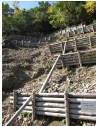
写真 間伐材を用いた土留め (土留め上に稚樹が出始めている)
