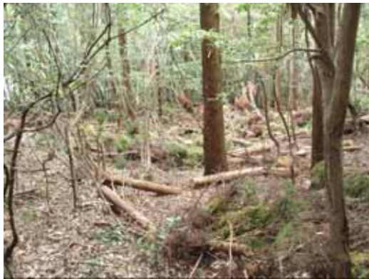
写真の説明：復元間伐の様子 人工林を間伐して照葉樹林を自然発生させる。
