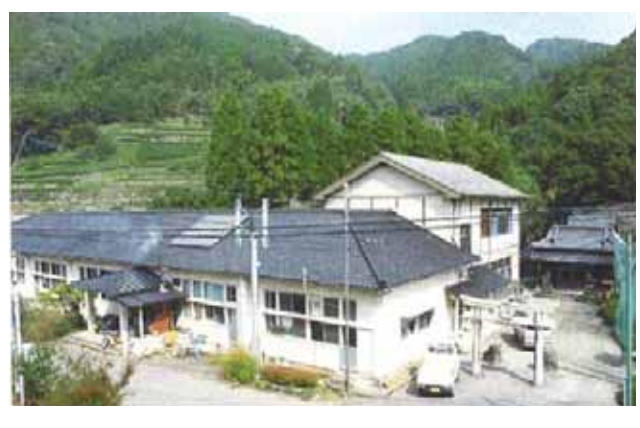
撮影時期：2007年9月 写真の説明：元小学校だった校舎を都市と農山村との交流、農林体験活動の拠点として活用している。太陽光発電パネル、小型風力発電機、薪ボイラー、薪ストーブ、オガクズバイオトイレなどを設置。周囲は棚田と里山に囲まれ、校舎のすぐ裏側には川が流れている。
