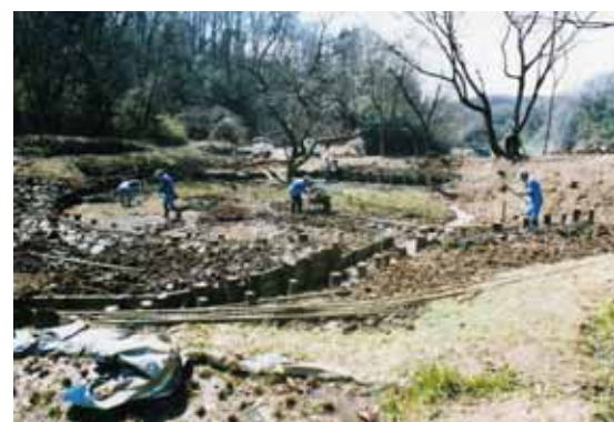
溜池の復元作業の様子
