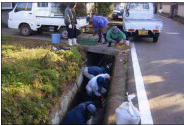
写真の説明：地域住民による緒方疎水の補修作業。
