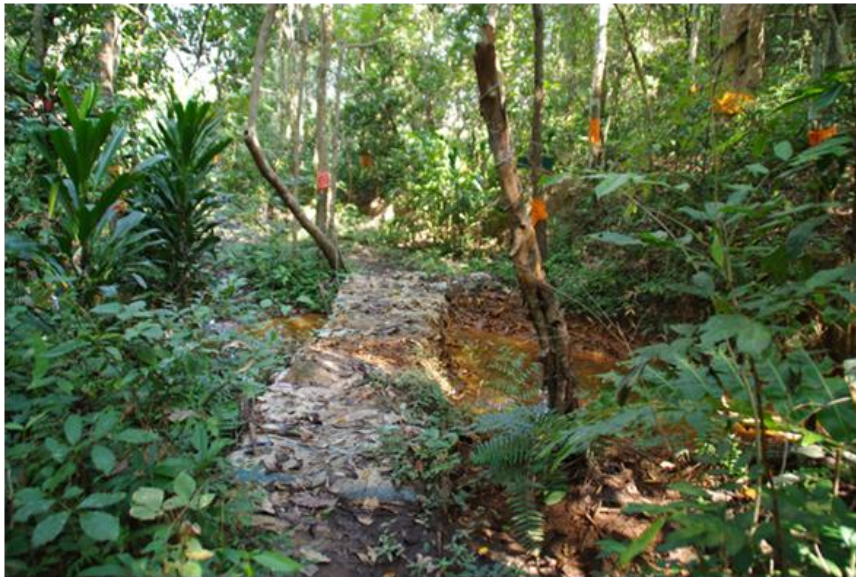
写真14 チェックダム
