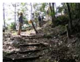
園路修復作業
