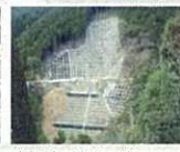
崩壊地の復旧工事
