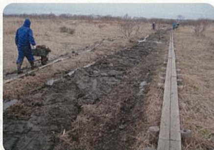
水抜き水路の埋め戻し
