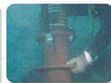
泥土除去状況（吸引）
