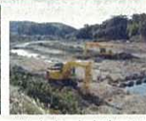
川にたまった土砂を取り除く工事
