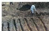
土砂堆積部分の浚渫
