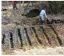
土砂堆積部分の浚渫
