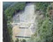
崩壊地の復旧工事
