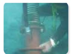
泥土除去状況（吸引）
