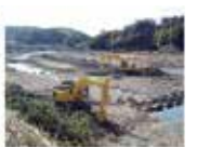
川にたまった土砂を取り除く工事
