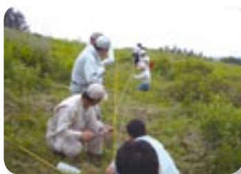
植生帯と防護柵の設置状況
