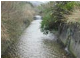
湿原内のコンクリート三面張り水路
