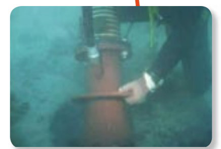
泥土除去状況（吸引）
