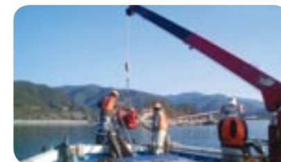
小型クレーンと排砂ポンプ
