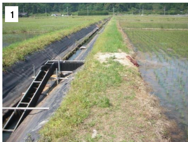
図 3.2-2 水田に設置された魚道と水田魚道
