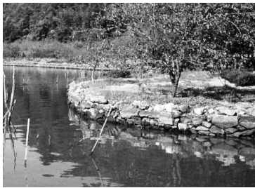
石積み護岸（昭和 50 年頃）
