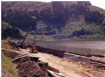
コンクリート護岸工事（昭和 50 年頃）
