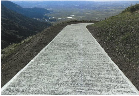
コンクリート舗装（融和・二区坂下牧野）
