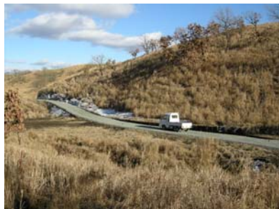
コンクリート舗装（湯浦牧野）
