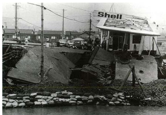
図 1-17.長尾川の決壊（長尾川橋上流右岸側） 出典：記念誌「大谷川放水路」
