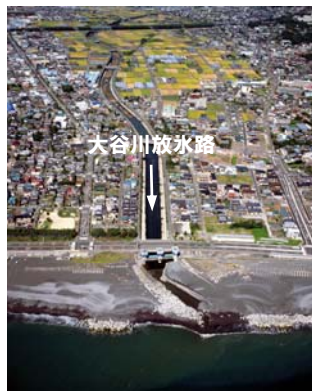
図 1-19.大谷川放水路
