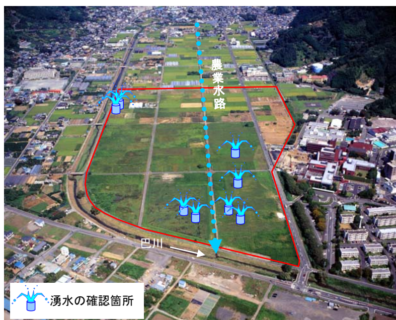
図 1-29.第 1 工区の湧水確認箇所
