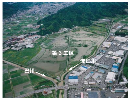
図 1-20.出水時の麻機遊水地（第 3 工区） (撮影：H15.7.4)
