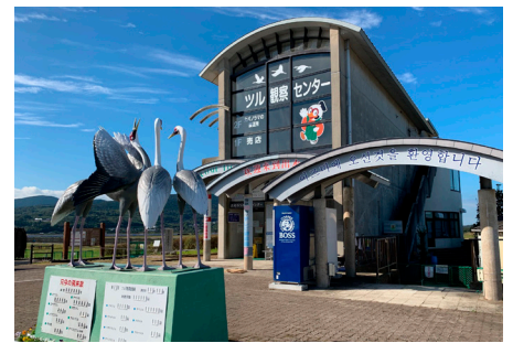
出水市ツル観察センター
