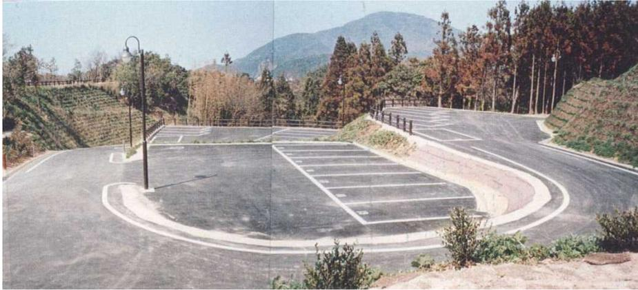
地形に合わせて2段に造成した駐車場。自然地形を生かし土工量をできるだけ少なく押さえた事例。
