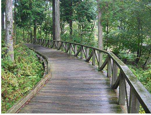
危険度に応じて、山側は立ち上がり、谷側は防護柵を設置している
