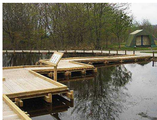
再整備後：車いす使用者も安全に利用しやすい構造の木道として再整備した
