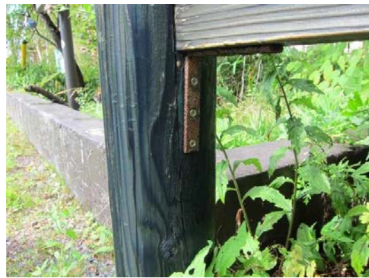
火山性ガスによる加圧注入材の変色 日光 NP
