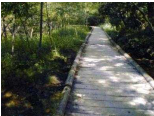
半割丸太を使用し自然景観と調和させた地覆の例 中部山岳 NP (上高地)
