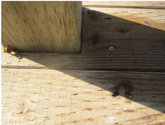
インサイジング加工の例 知床 NP
