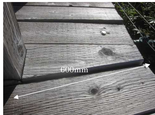
張出しが長いと、床材が反って暴れている例 知床 NP
