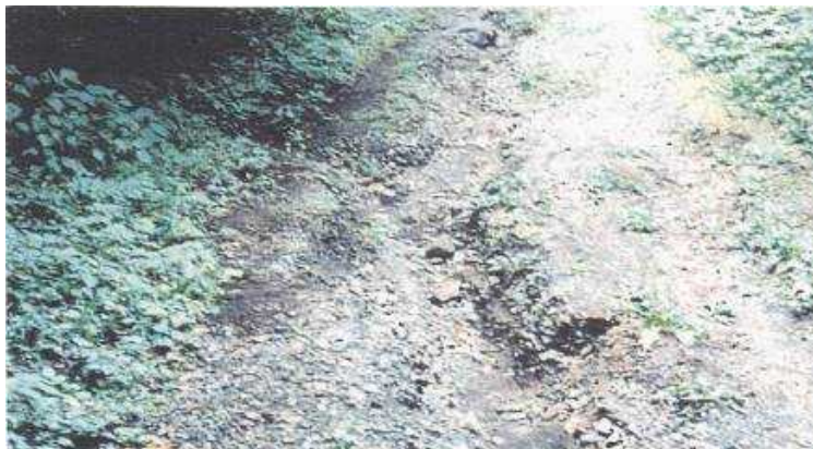
洗掘を起こしている例
