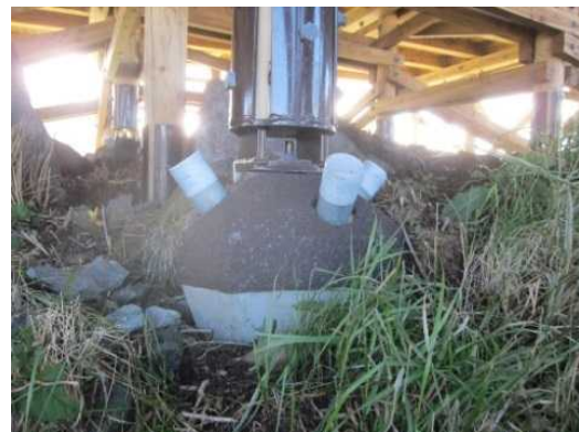
軟弱地盤に適した基礎を採用した例 知床 NP
