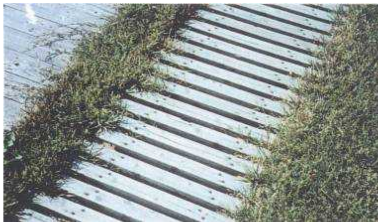
U字溝に木で蓋を掛けた例
