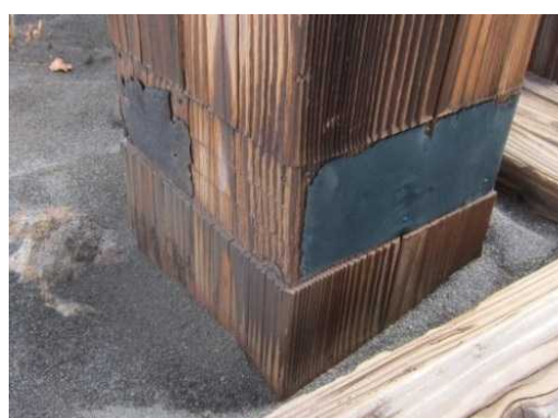
火山性ガスにより銅板が腐食した例 阿蘇くじゅう NP (砂千里)
