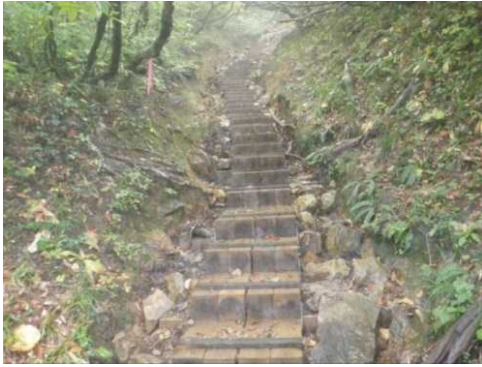
水みちとなっている歩道を覆うことにより洗掘を防止している例 中部山岳 NP
