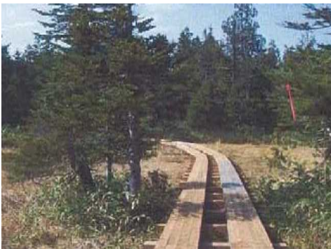
樹木を避けて、緩やかな曲線とすることで景観に調和させている例 尾瀬 NP
