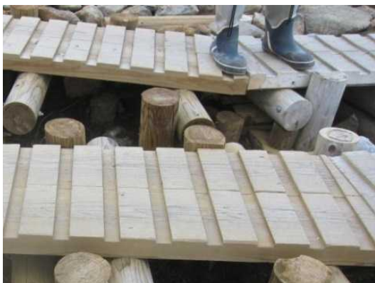
施工性を向上させるため、登山道において床板の有効厚を 60mm とした例 中部山岳 NP (黒菱唐松岳線歩道)
