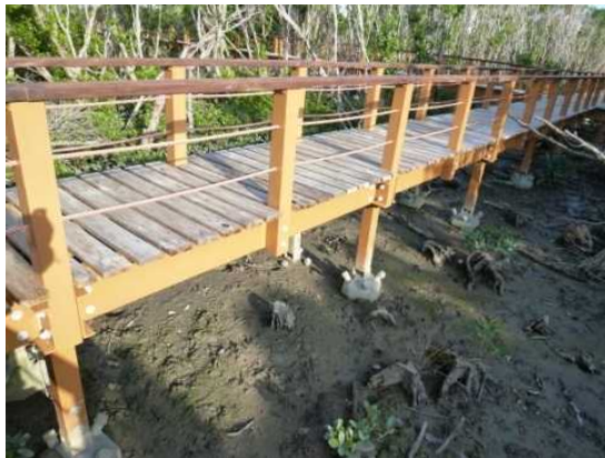
高温多湿な地域において柱及び大引に GRP を使用した例 国指定漫湖鳥獣保護区
