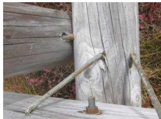
積雪によりボルト（M12）が曲がり、かすがいがぬけかかっている例
