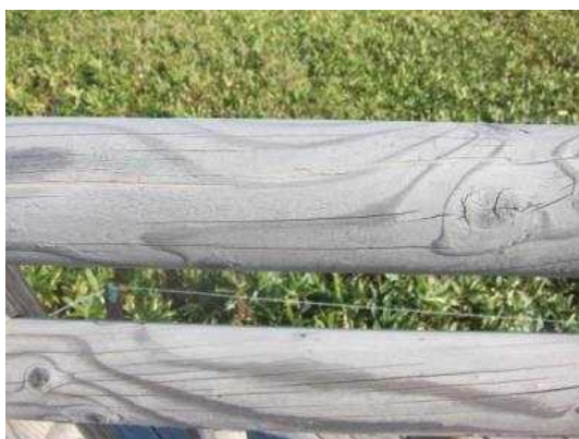
ささくれ防止のため、円柱加工の柵に目立たないように保護塗装を行った例 知床 NP
