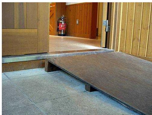
仮設の板を渡して段差を解消している
