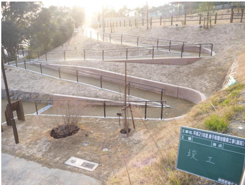
整備後（平成23年3月）
