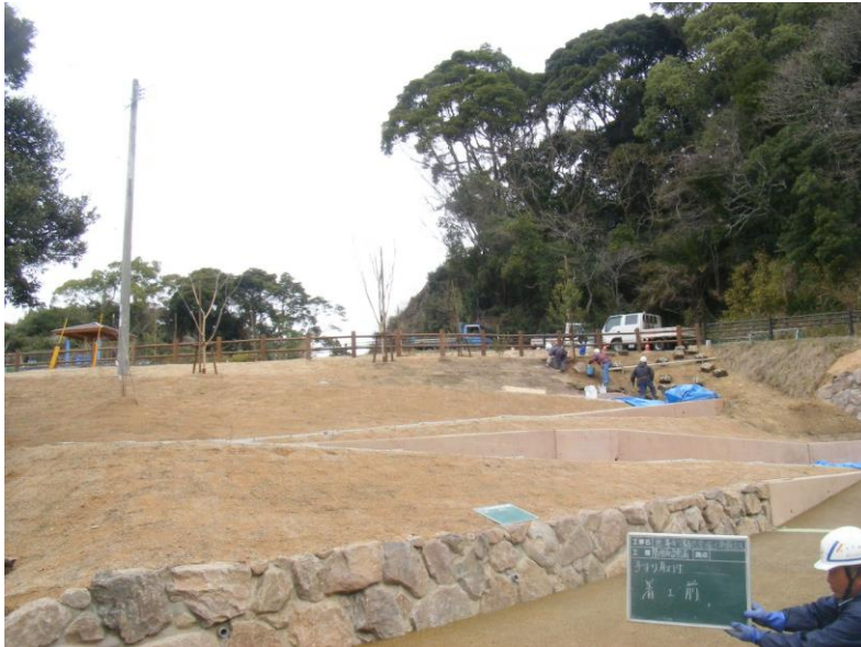
スロープ整備中（平成22年11月撮影）
