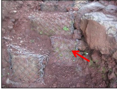
2009年施工箇所（施工後2年）
