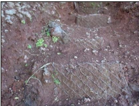
2008年施工箇所（施工後3年）
