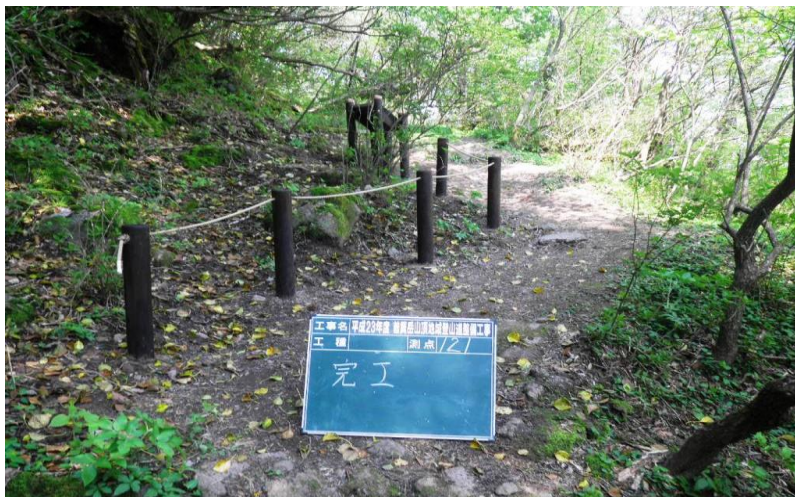
整備後 (H24. 5 (整備前と反対方向から撮影))
