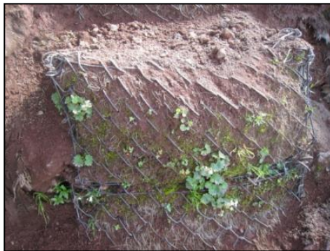
2007年施工箇所（施工後4年）
