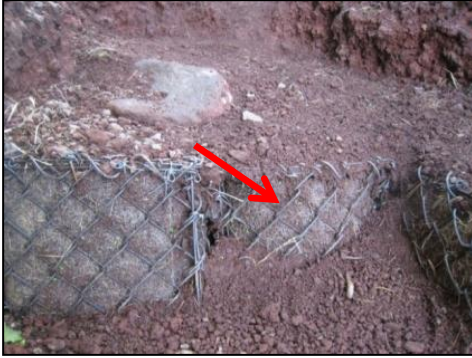
2010年施工箇所（施工後1年）
