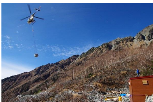
図 7-3. ヘリコプターによる便槽の搬出（写真は岳沢小屋）
