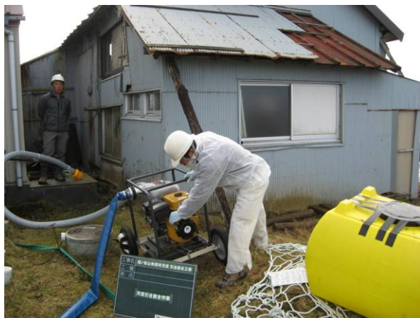
図 7-2. 汚泥引き抜き作業
