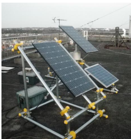
図 6-1. 太陽電池パネル (手前が固定式, 奥が太陽追尾装置上のパネル)
