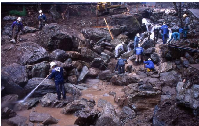
図-16 分散型落差工のイメージ
