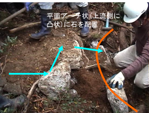
写真-17 石と石の間にこぶし大の石（飼い石）をしっかりとこまらせて、力が伝わり、一体的な構造になるように組む。周りの地面もしっかりとつき固める。
