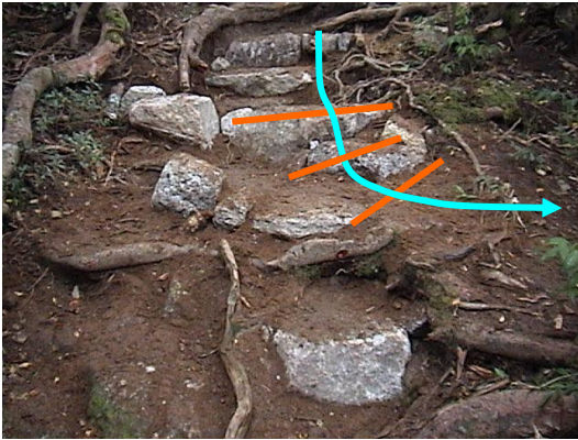
写真-18 水を誘導して排水する
