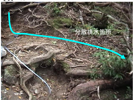
写真-16 試験施工地点 A
