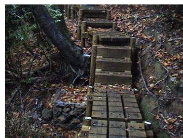
写真-3 布団かごによる浮き上がり部段差の処理
