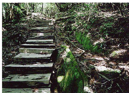
写真-8 土埋木を利用した近年の整備(楠川歩道)
