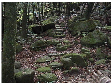
写真-2 益救参道の整備
