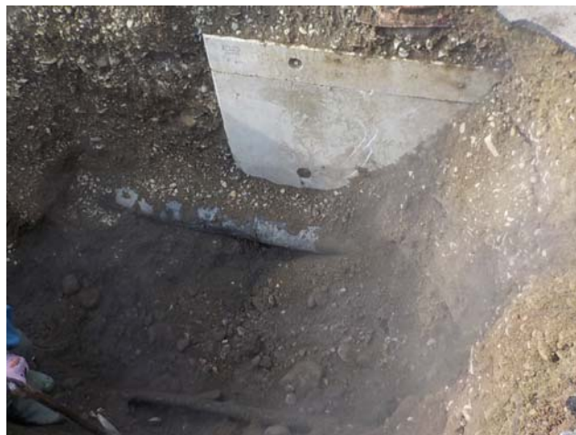
中央の温泉管が老朽化し破断（手前は水道の給水管）
