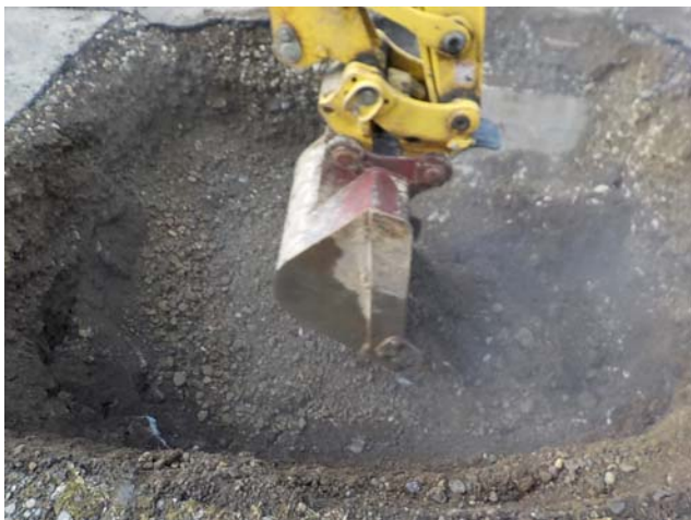
掘削（お湯は止めているが熱風と高温により危険）
