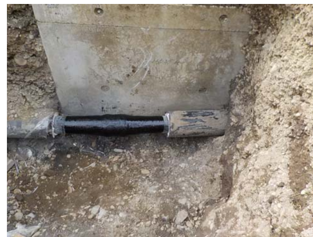
FRPの化学反応が収まるまで約2時間以上放置し埋戻し まれに付が悪く漏れた場合はじめからやり直し
