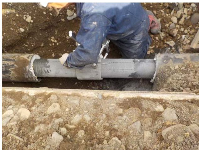
造船業者の自作ソケットによる破断部分の補強
