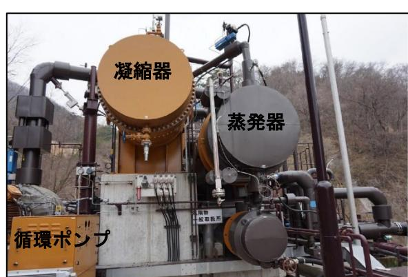
写真6 蒸発器・凝縮器
