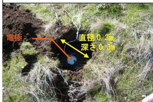
埋設前の状況
