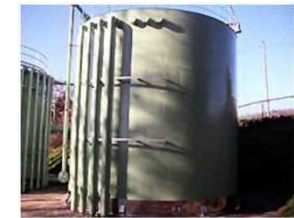
貯湯槽（保温後）
