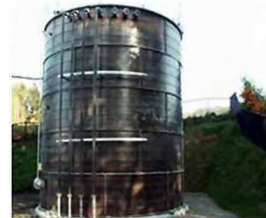
貯湯槽（保温前）
