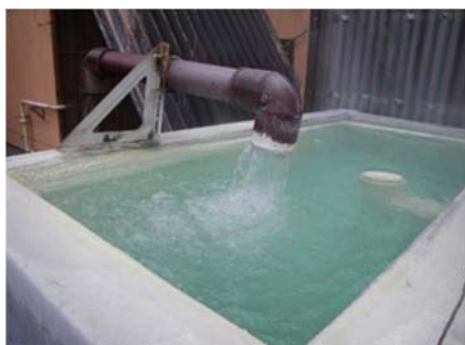
図 2 落下式ばっ気槽
