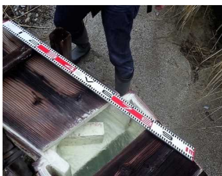
図 8 樋の中に設置されたレンガ
