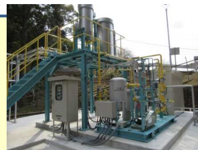
メタンガスコジェネレーションシステム
