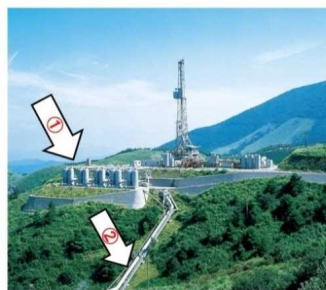
○八丁原発電所2号機 坑井基地
