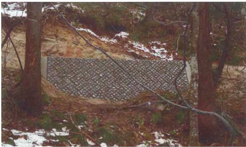
ナチュロックを用いた擁壁の修景
