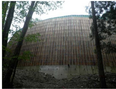
間伐材を用いた擁壁の修景
