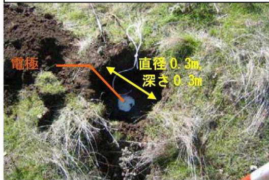
埋設前の状況
