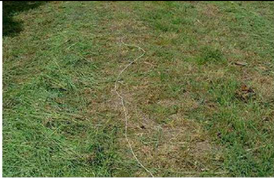
電線の敷設状況
