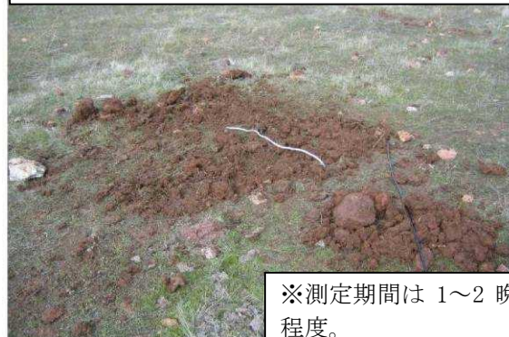
埋設後の状況
