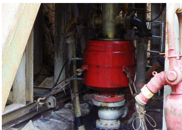
アニュラータイプ BOP 設置状況
