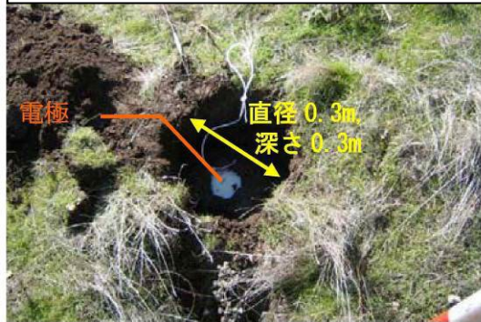
埋設前の状況
