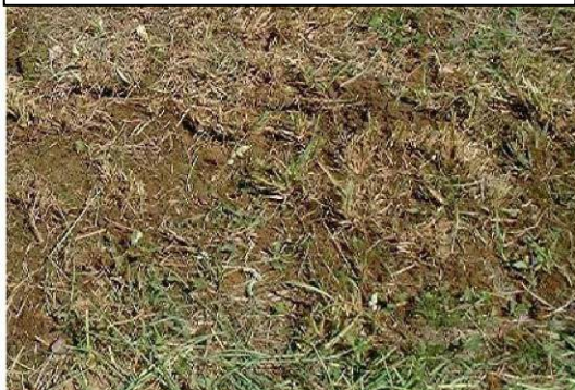
コイル埋設場所の埋め戻し後
