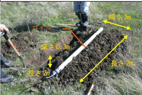
コイルの埋設状況
