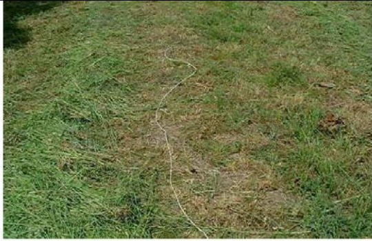
電線の敷設状況
