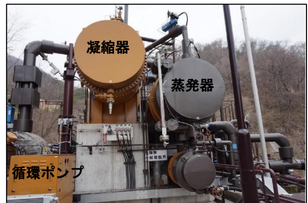
写真6 蒸発器・凝縮器
