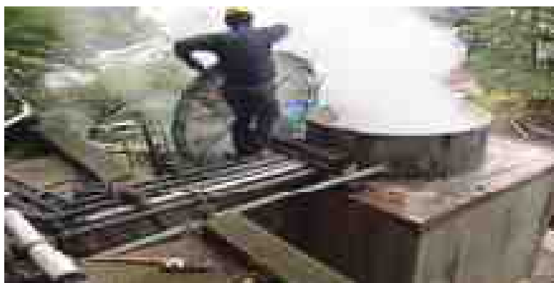
【保守点検の様子】
