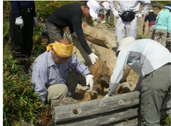
歩行路誘導の柵を設置
