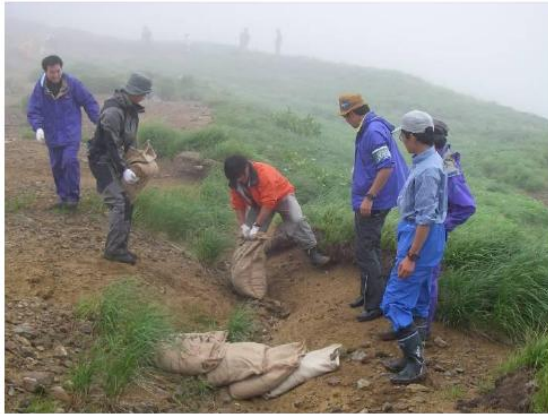
流水コントロールとして、土のう袋を設置
