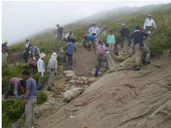
緑化ネットを敷設
