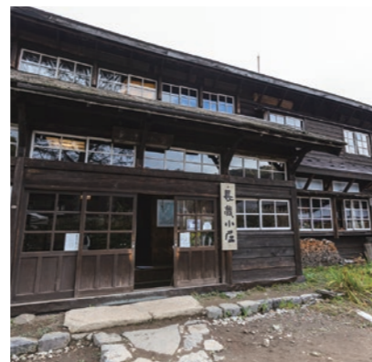
1934年に建てられた歴史ある木造の建物。尾瀬沼周遊や燧ヶ岳登山で多くの方に利用される。
