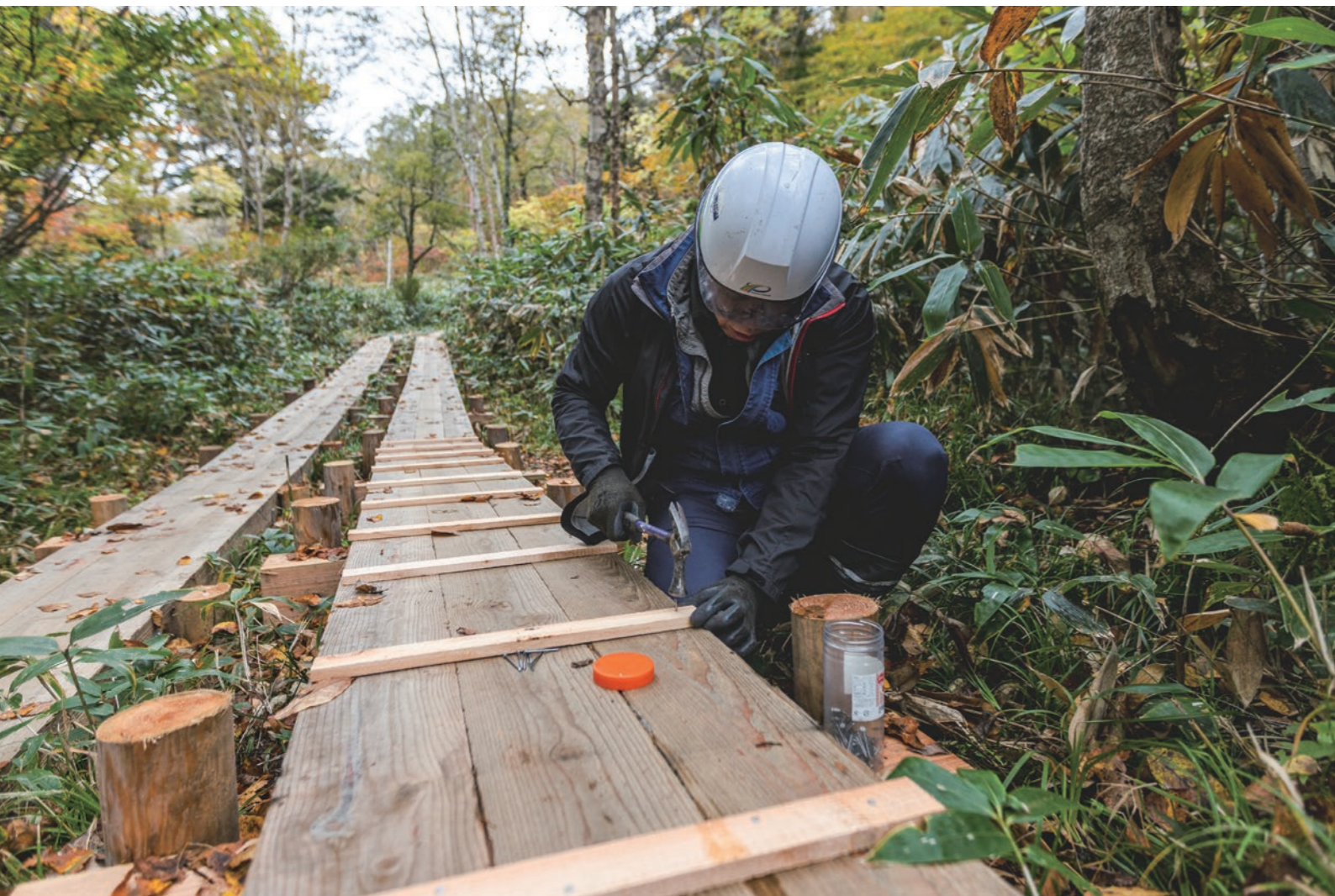
木道の栈木を補修する宮澤さん。こうした地道な作業が登山者の安全を守っている。
