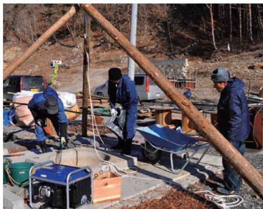
番屋群再生に向けた取り組み。井戸の復旧作業の様子
