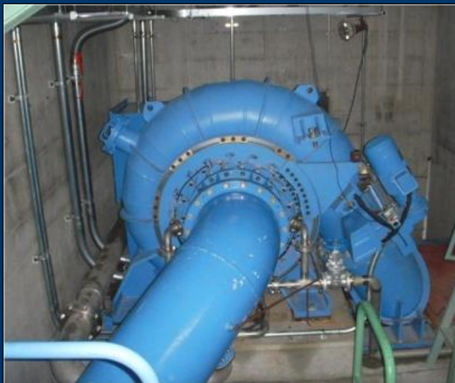
写真 - 設置した横軸フランシス水車
