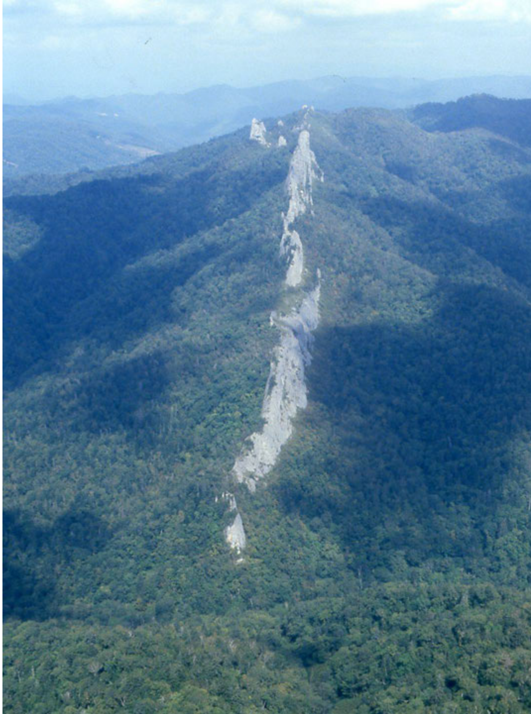
上空から見た南面 (ヘリコプターより)
