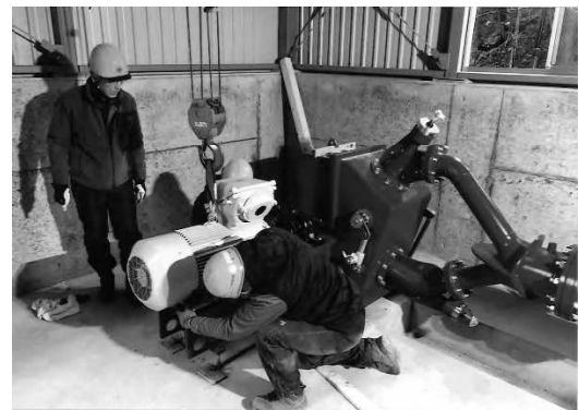
【発電機の設置】
