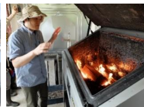
バイオマスボイラー
