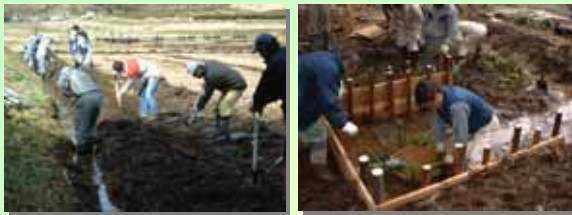
水路畦畔づくりや水路畦畔へのセキショウの入植、水源の養生等を実施
