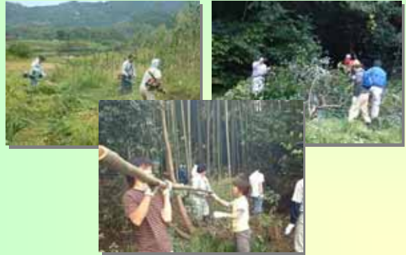
平成17年10月29日 生き物の里保全再生活動
