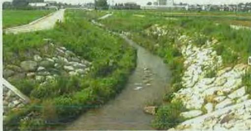
緩傾斜の緑化護岸が採用されているが、画一的な定規断面であり、河床も平坦で流れに変化が見られない。また、河床幅も狭い。
